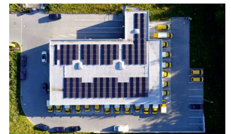
CO 2 -neutraler Zustellstützpunkt
